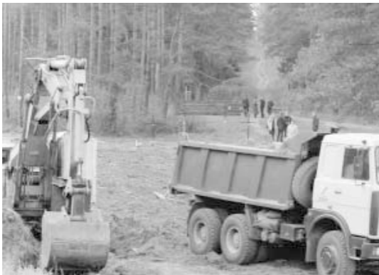
Пачатак будаўнічых работ, 24 верасня 2001 году.
